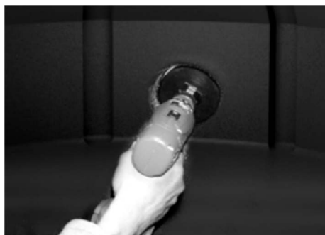
Рис. 2 Обработка отверстия под установку ТГП изнутри колодца
